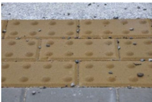
1 pav. Tektilinių trinkelėlių pvz.
