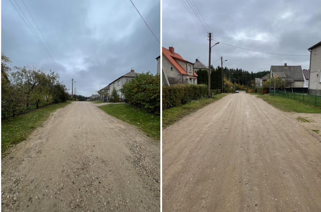
2. pav Neringos gatvės esama būklė
